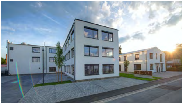
SECO Coburg. Quelle: SECO
